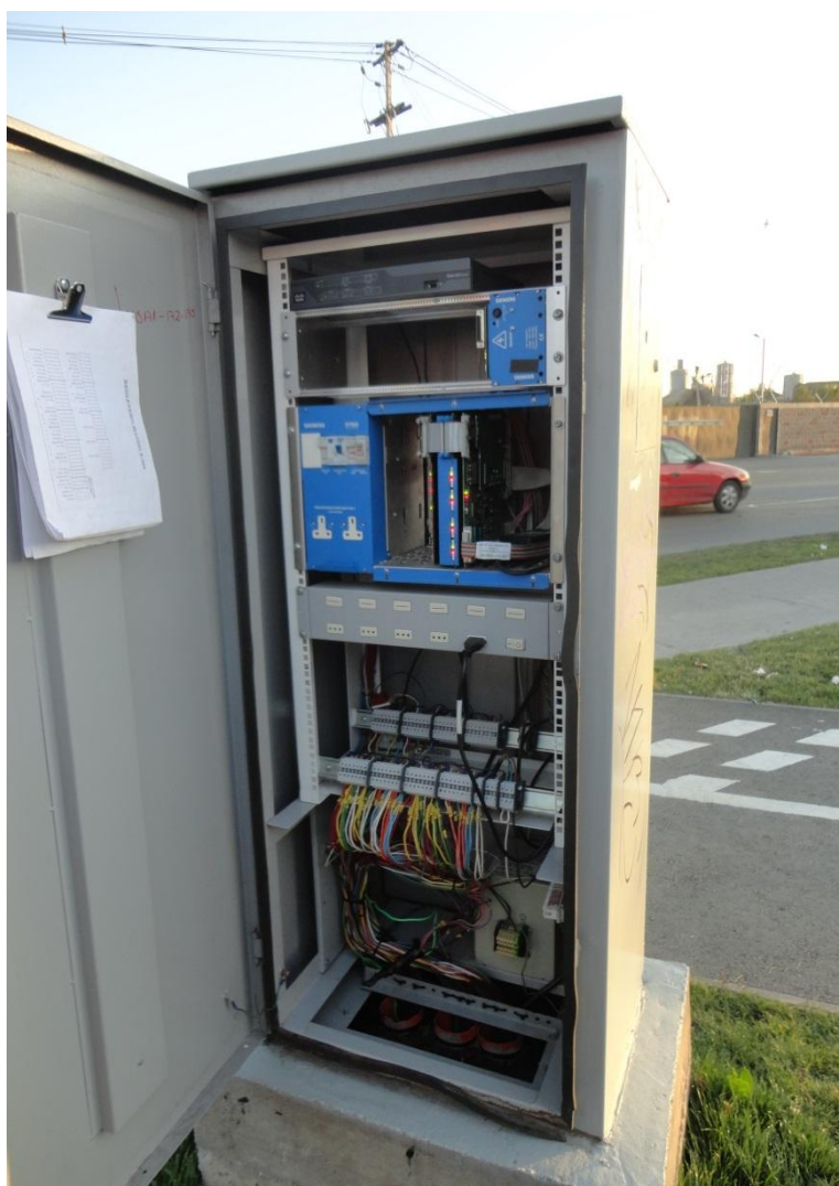
Foto 5 – Controlador Semafórico ST900 com OTU UTMIC
