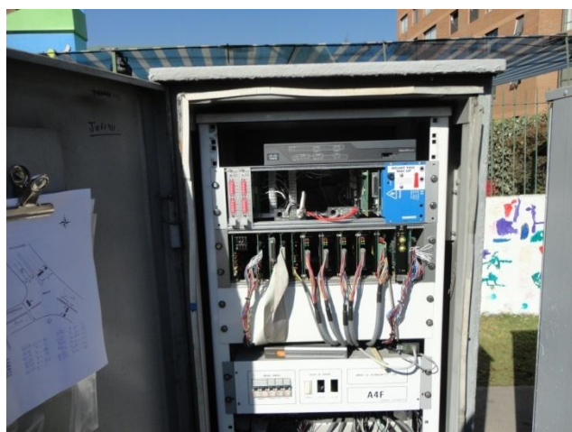
Foto 4 – Detalhes do controlador da AUTER - Av. Patagônia x R. Los Domingos
