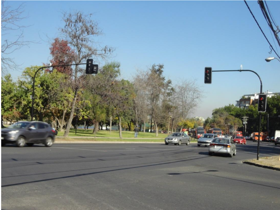
Foto 14 – Transmissão Wifi de transmissão de dados para o controlador sem a necessidade de fiação aérea ou subterrânea
